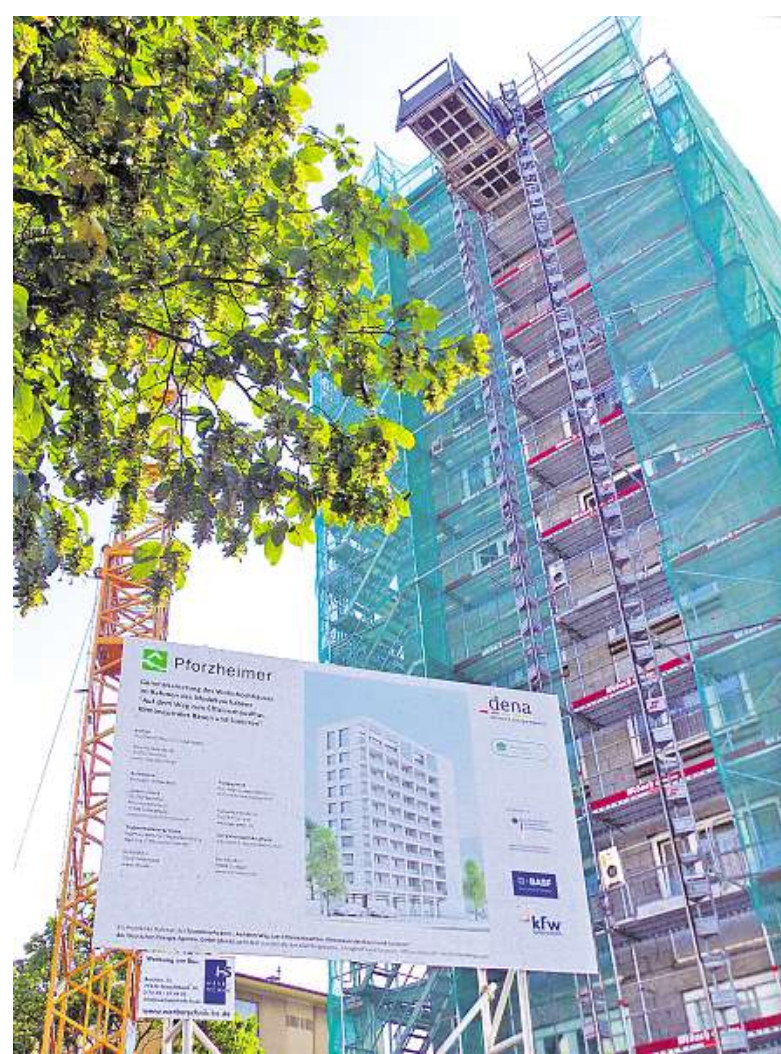
Das Bauschild zeigt, wie das frühere Eisenbahner-Wohnhaus künftig aussehen wird.
