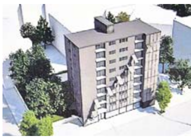
... die Balkone und die Platten fallen. ...
